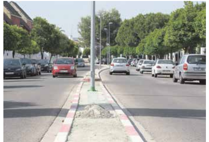
Mediana sobre la que se está actuando
