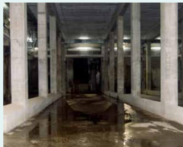
El tanque de tormentas, con capacidad de hasta 16.133 m<sup>3</sup>
