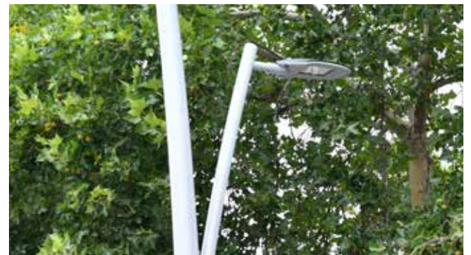
Nuevas farolas LED instaladas en la Alameda Santa Eufemia
