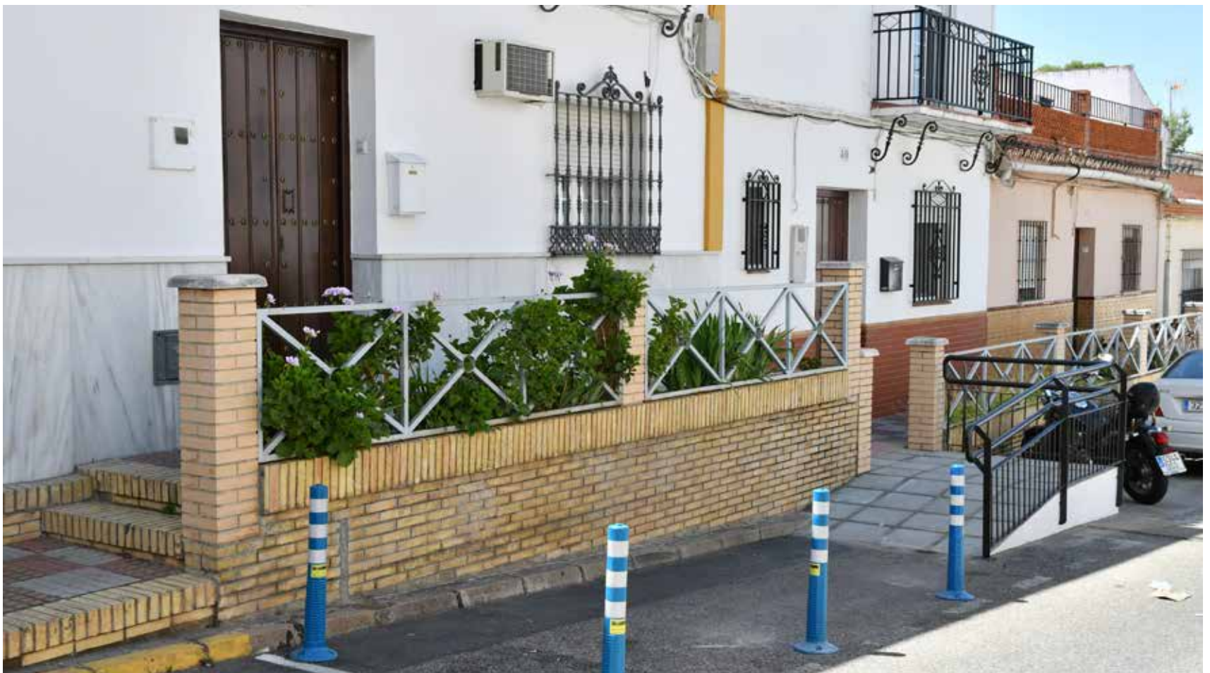
Rampa adaptada para movilidad en la calle Carlos Cano, una de las actuaciones ya terminadas por el Ayuntamiento para reducir las barreras arquitectónicas
