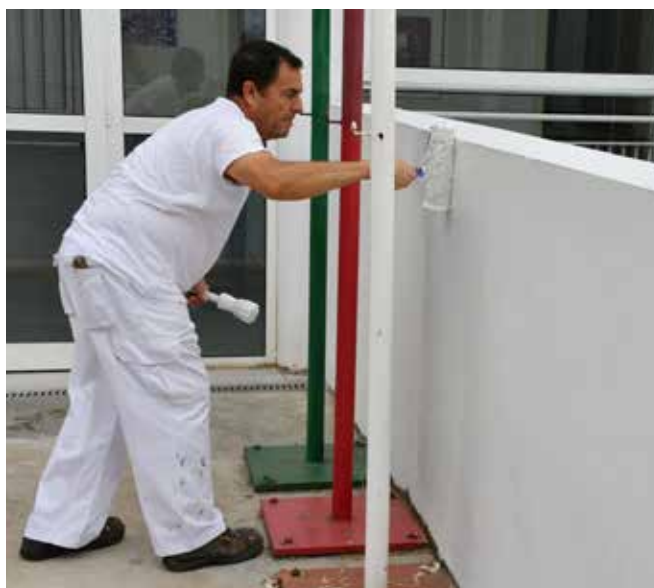
Operario realizando trabajos de mantenimiento en el Infanta Leonor
