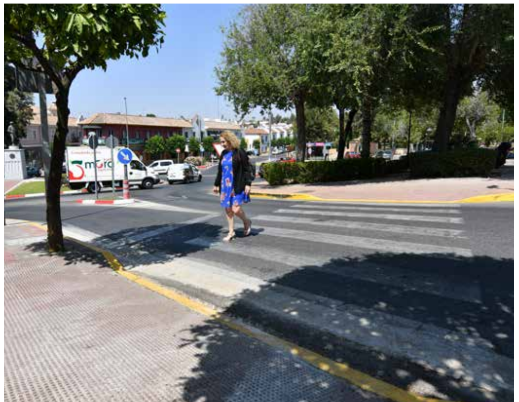
Adecuación de un paso peatonal en la calle Aljarafe, junto a la rotonda del Bombita
