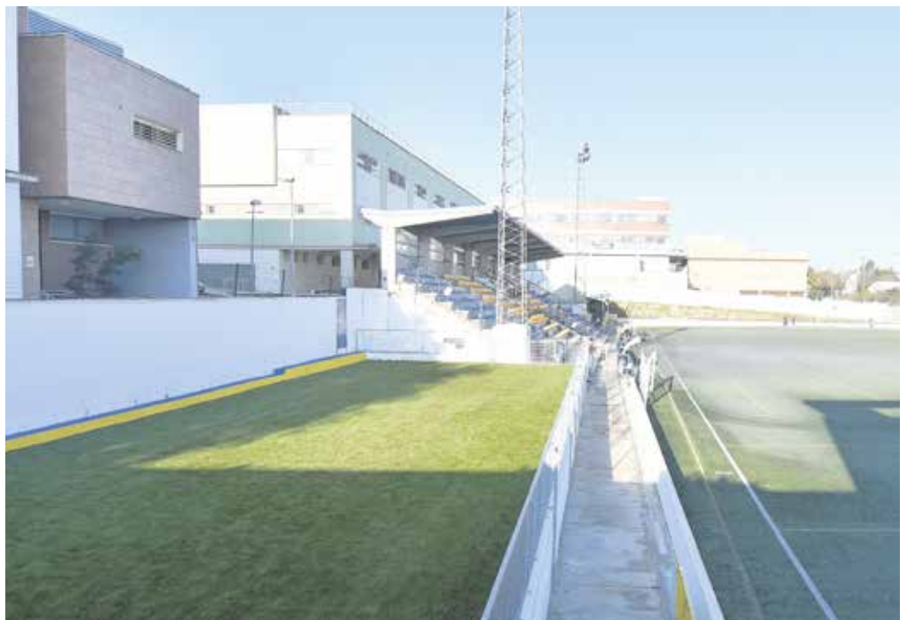
Nuevo campo de entrenamiento -a la izquierda- ya finalizado tras las obras
