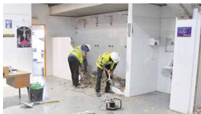
Operarios trabajando en la reforma de los nuevos vestuarios del estadio
