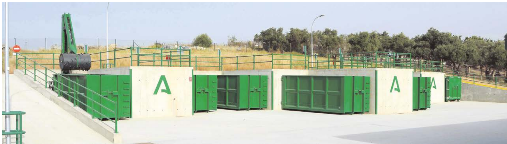
El Punto Limpio, en la calle María Moliner, cuenta con más de 5.000 m 2 de superficie y tiene una capacidad para tratar 906 toneladas al año de una gran variedad de residuos
