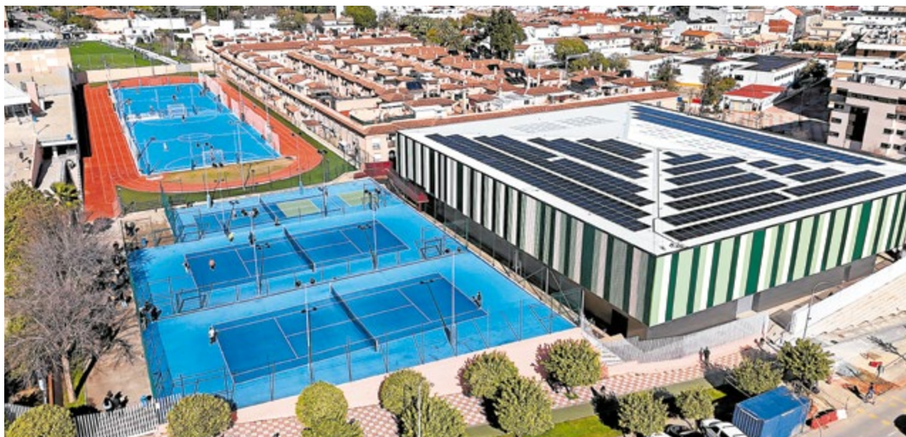
Vista aérea del Pabellón Polideportivo Mascareta donde se puede apreciar la instalación de placas solares en su tejado
