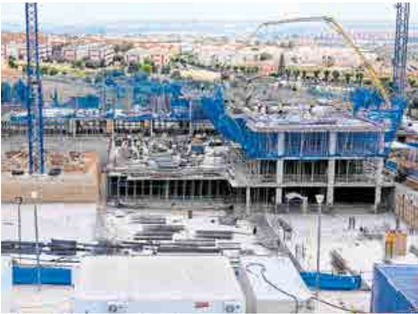
Construcción de viviendas en una parcela de Tomares
