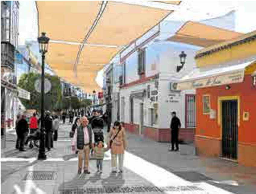
Instalación de los toldos en las Cuatro Esquinas
