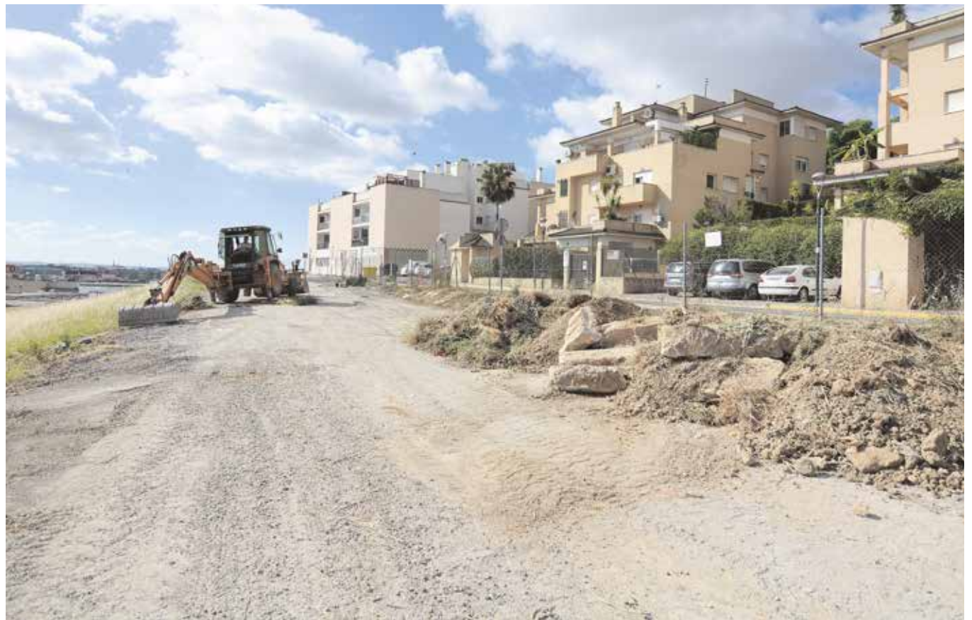
Las obras del aparcamiento ya han empezado en la calle Pureza cuyas 40 plazas serán asfaltadas
