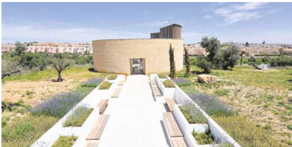
Vista exterior del Aula de la Naturaleza del parque
