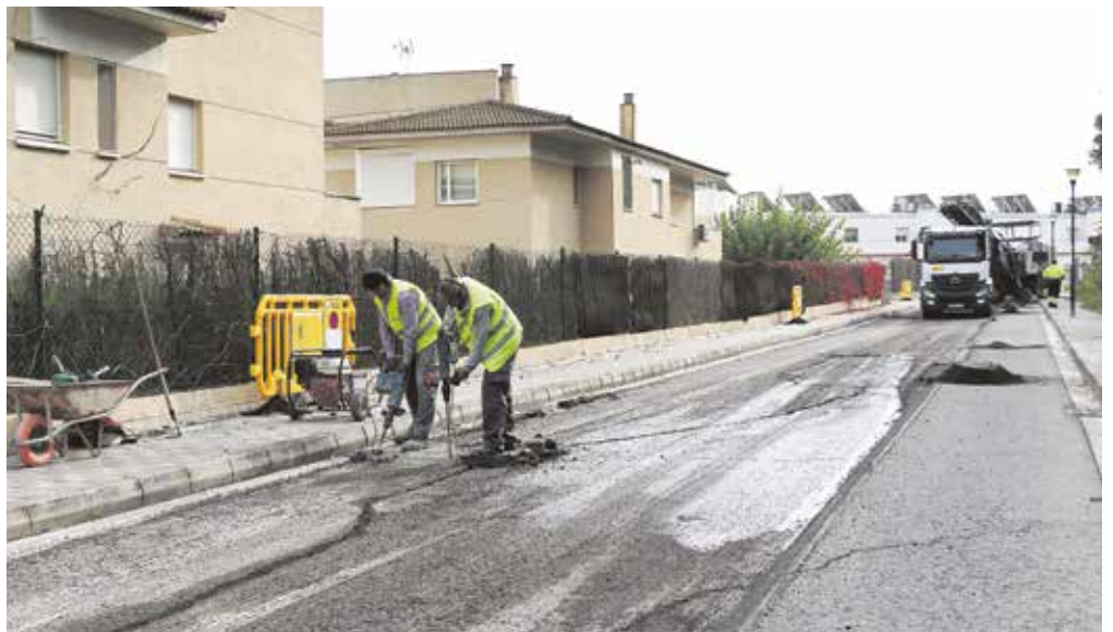
Dos trabajadores realizando labores previas al asfaltado en el tramo final de la calle Triana
