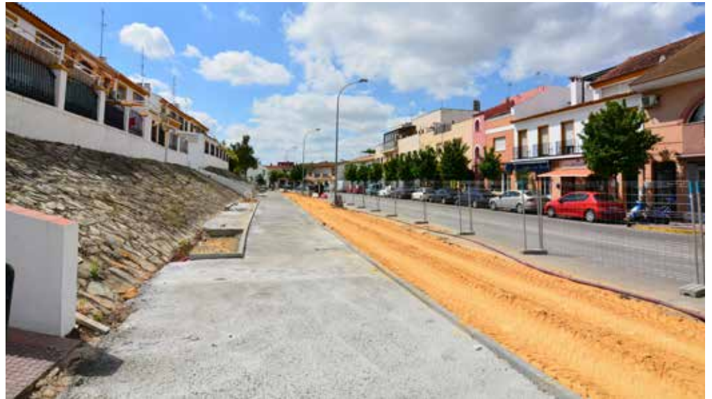
Estado actual de las obras en la Alameda de Santa Eufemia
