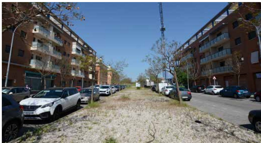
Las obras de mejora del bulevar de la Avda. del Olivar se dotarán con un presupuesto de 118.902 euros
