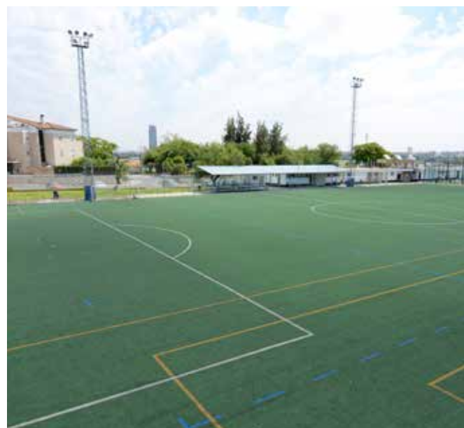
El césped del campo municipal del Camino Viejo CF será sustituido
