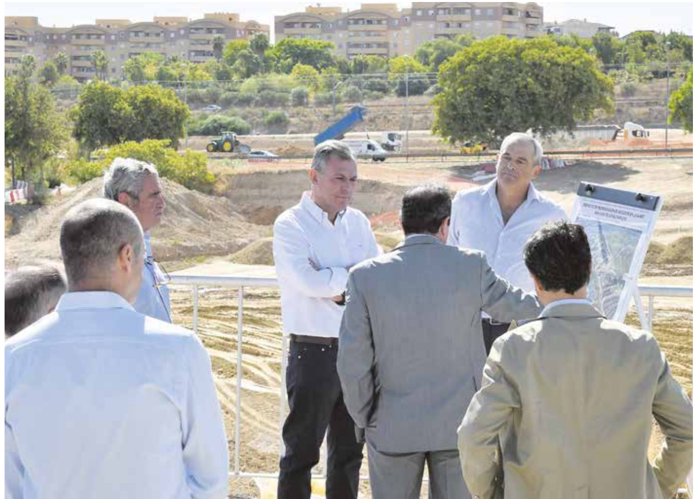
El alcalde, junto a los técnicos y promotores de la obra, durante su visita al futuro acceso que conectará Tomares con la autovía A-8057
