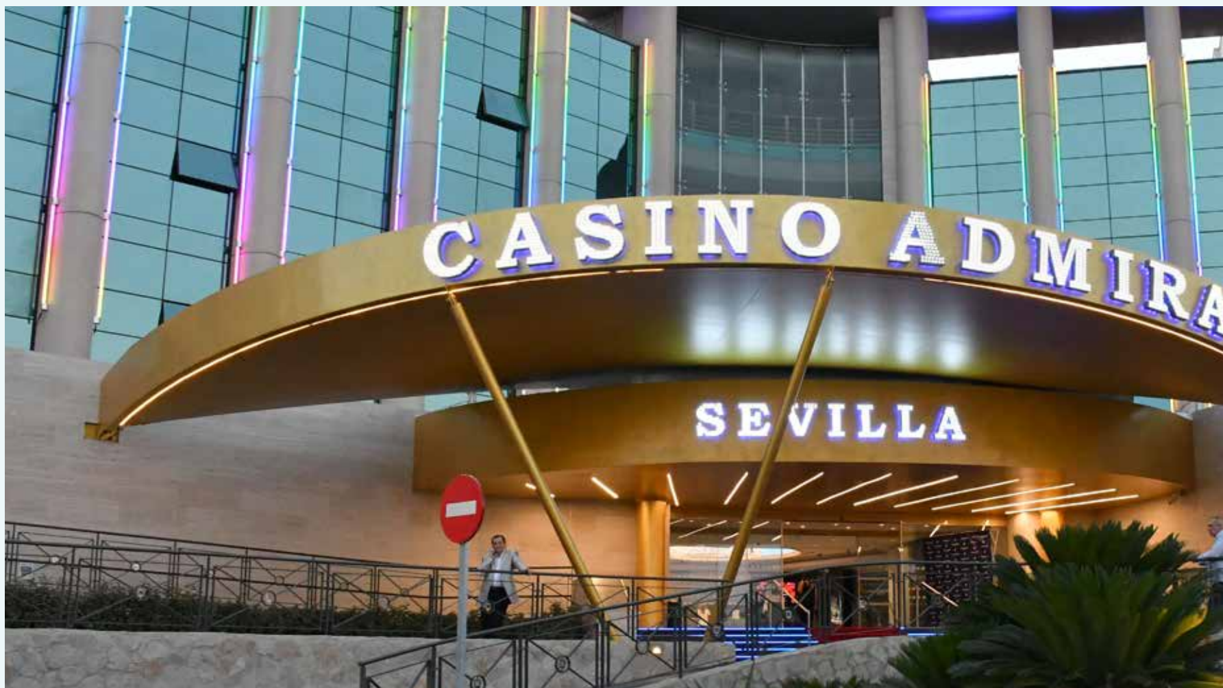
Fachada del Casino Admiral Sevilla tras las obras de reforma que se han llevado a cabo
