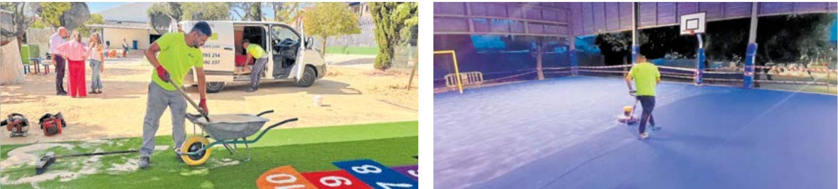
Operarios trabajando en las mejoras del Juan Ramón Jiménez, fruto de la inversión en Educación realizado por el Ayuntamiento de Tomares
