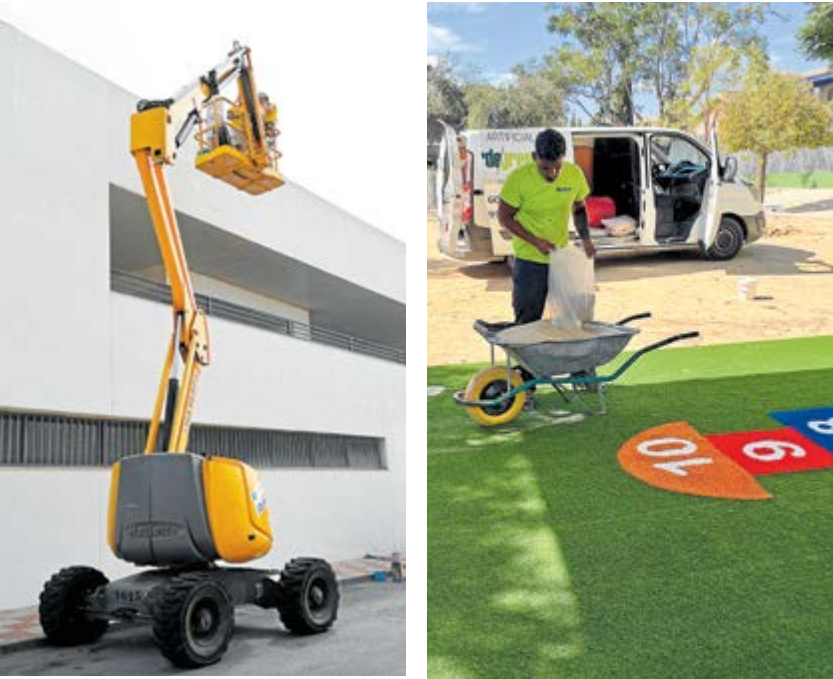
Operarios trabajando en los arreglos del colegio Juan Ramón Jiménez
