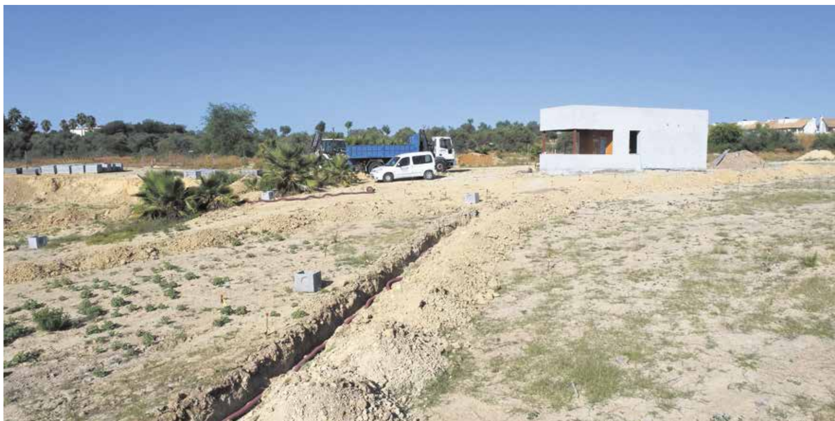
Las obras del quiosco que se está construyendo en el Parque Olivar del Zaudín avanzan adecuadamente
