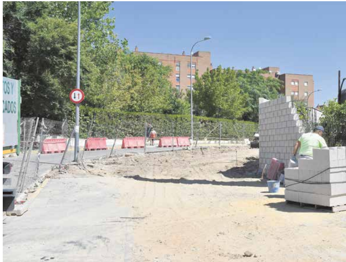
El derribo del muro de la Hacienda de Santa Eufemia va a permitir el desdoble de la vía
