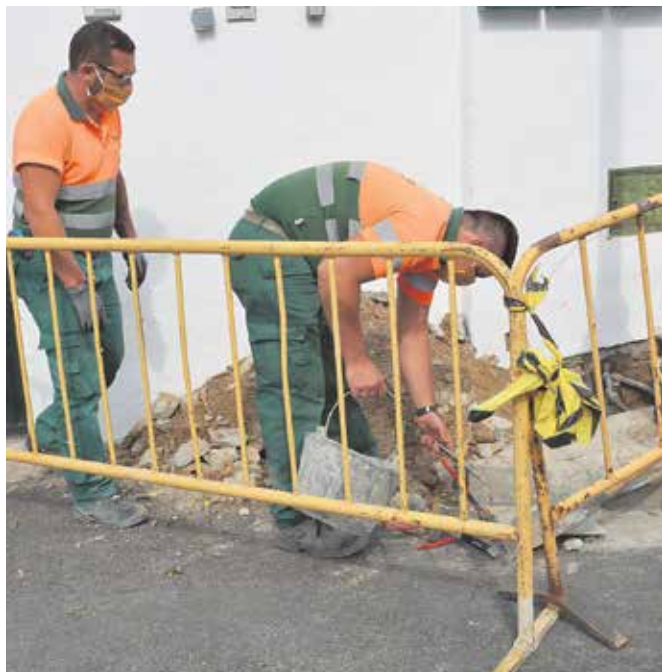
Obras en la calle El Recreo (Sport Aljarafe)
