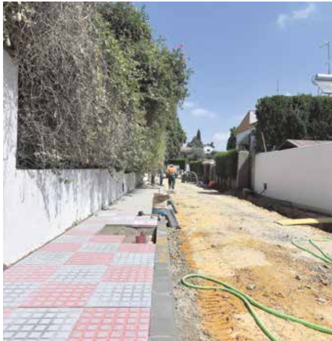
Las obras de la calle Badajoz (Las Almenas) están finalizando
