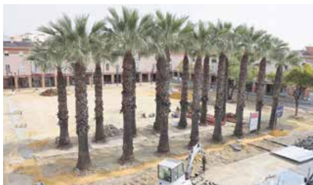
Estado de las obras
