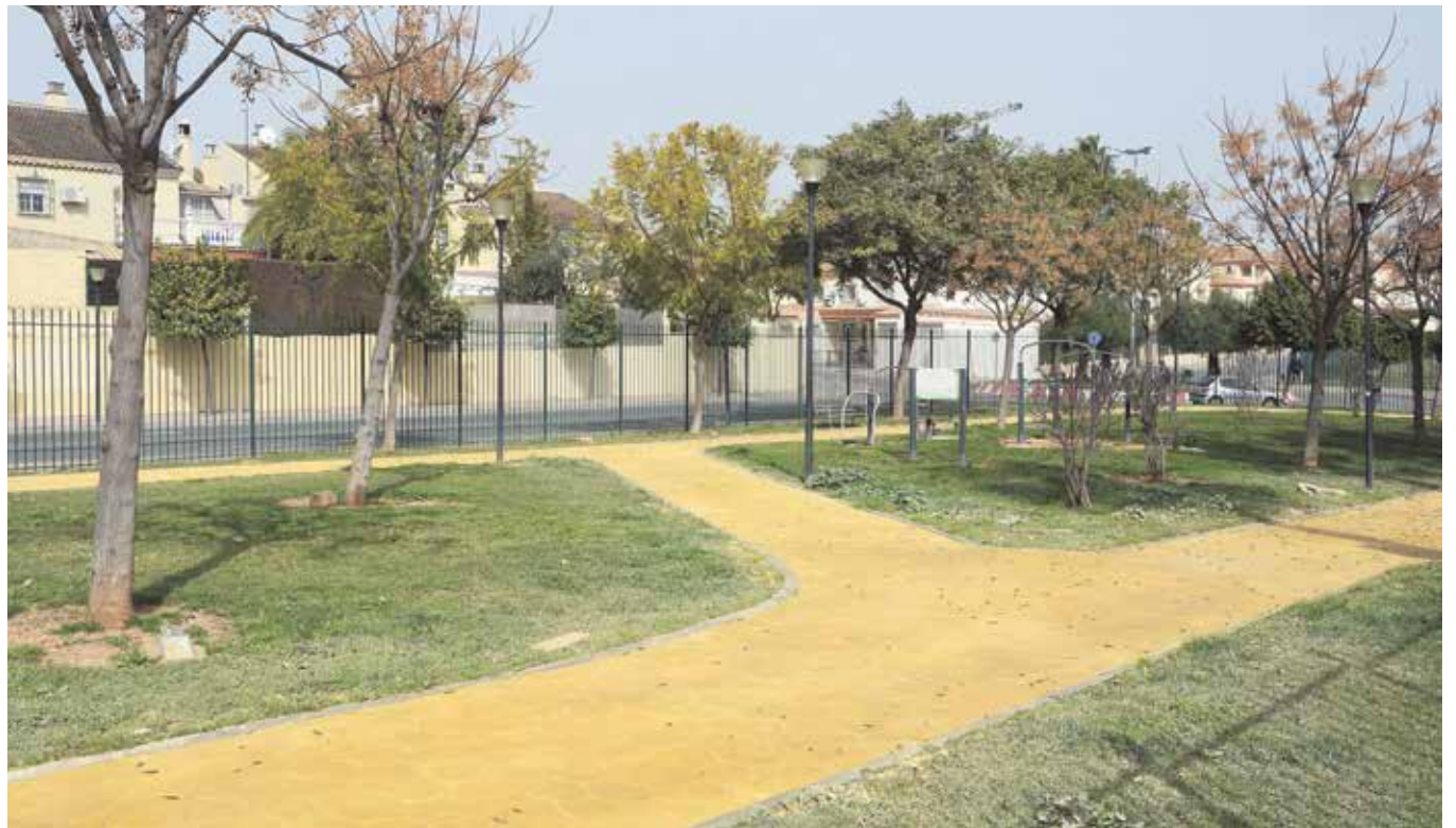
Los trabajos han consistido en rebajar unos 10 centímetros el albero de los senderos y sustituirlo por hormigón impreso
