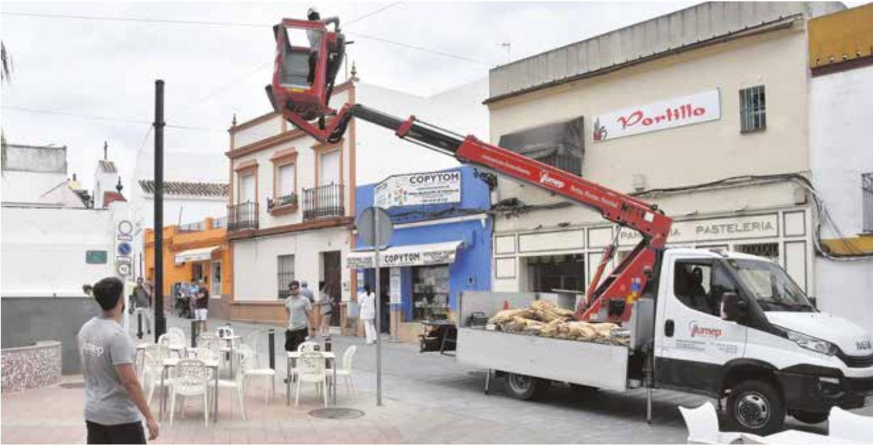
Operarios utilizando una grúa para la instalación de los toldos en la zona peatonal del municipio de Tomares para hacer frente al calor veraniego.
