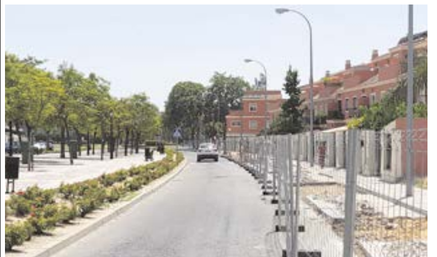
Trabajos de arreglo y repavimentación en la calle Rosalía de Castro
