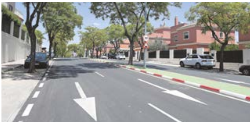
Entre las medidas llevadas a cabo, destaca la repavimentación de viarios públicos
